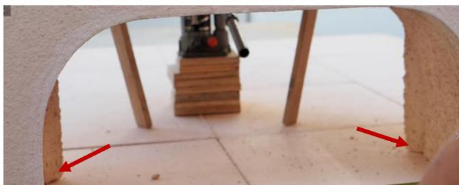
Si les grands voussoirs dépassent à l'intérieur du four, ce n'est pas grave. La pièce d'entrée est taillée de biais et l'ouverture de 44 cm ne sera pas diminuée.
