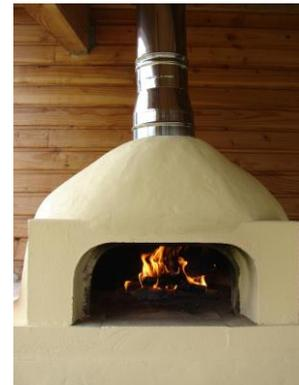
**Welche Form der Ofen am Ende auch haben wird, wenn er außen aufgebaut wird, muss sich ein ausreichend großes Dach darüber befinden, damit der Ofen bei schlechtem Wetter keine Feuchtigkeit aufnimmt.**
