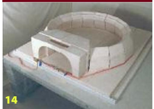
**14** Um den Aufbau zu sichern, ein Spanngurt platzieren.
