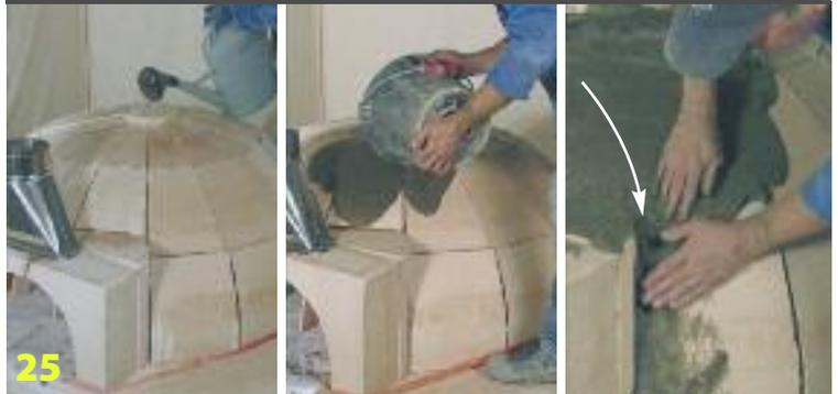
Der Mörtel nach der auf den Sack beschriebenen Anleitung vorbereiten. Die Gewölbe anfeuchten. Den Mörtel von oben bis unten auflegen. Die Zwischenräume und die Basis der Abzugshaube gut abdecken. Ein paar Minuten trocknen lassen. Den Spanngurt wegnehmen und den Rest des Mörtels bis das Boden gießen.
