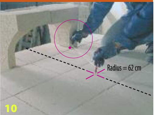
**10** Einen Kreis (radius: 62cm) wie gezeigt abzeichnen (Nagel, Bindfaden, Stift). Der Kreis wird mit der Verlegung der Bausätze helfen.
